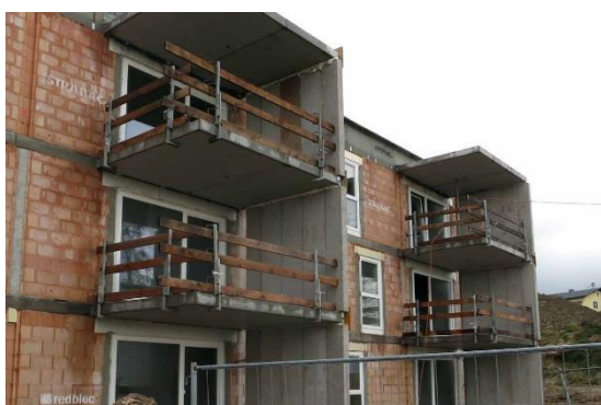
Abbildung 5: Balkontrennwand Rohbau
