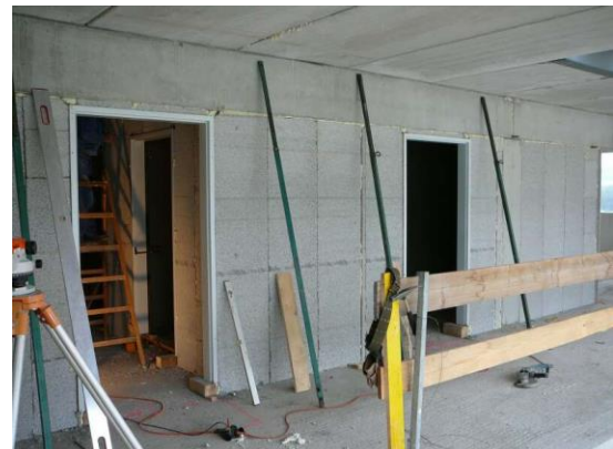
Abbildung 4: Einbau von Türen
